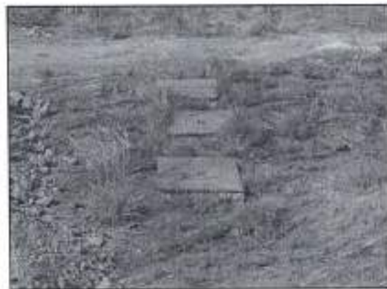
Foto 10: Poços de medição no Aterro Sanitário.
