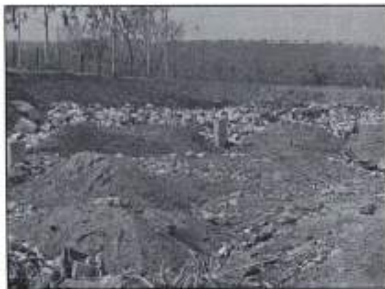
Foto 8: Drenos para gases oriundos da decomposição de matéria orgânica.
