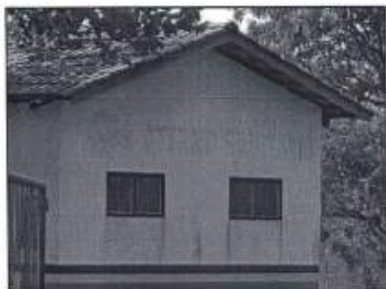
Foto 5: Espaço administrativo do Aterro Sanitário.
